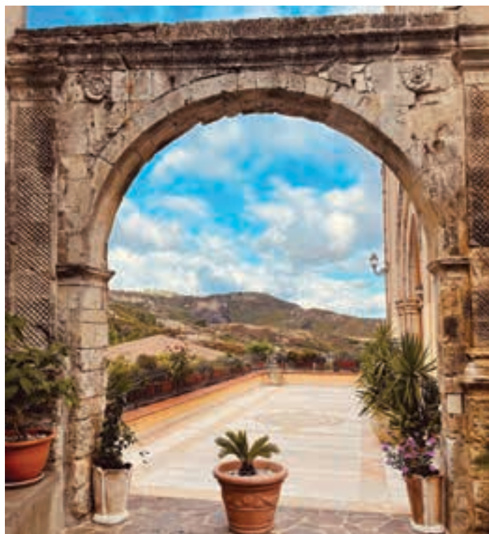
Immagine anteriore prima degli interventi di restauro
