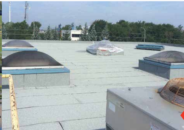
Réfection de la toiture en bicouche élastomère blanche de la boulangerie Weston à Longueuil
