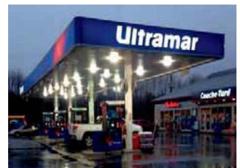
Stazioni di servizio Ultramar
