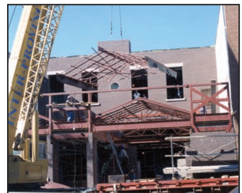
Luglio 1988 - Struttura mobile del tetto
