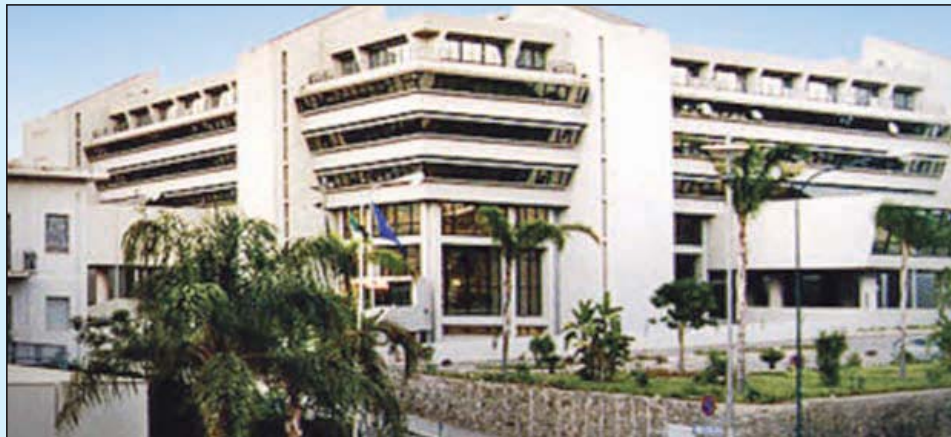
La sede del Consiglio Regionale della Calabria il Palazzo Tommaso Campanelle.
