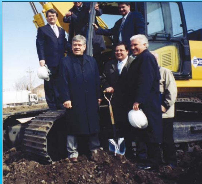
Il centro ricreativo e la caserma dei pompieri di Rivière-des-Prairies hanno visto la luce grazie all'intervento politico dell'On.le Tomassi. Nella foto l'inaugurazione dell'inizio dei lavori del primo Scavo che lui stesso ha iniziato.
