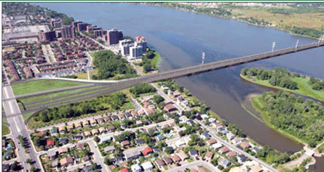
Così sarà il nuovo ponte dell'autostrada 25 sulla Rivière-des-Prairies
