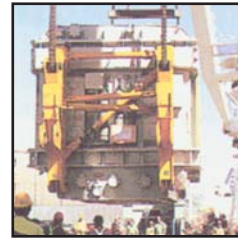
Levage d'un transformateur de 362 tonnes
