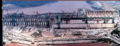
Una diga a gravità con una lunghezza totale di 2309 metri
